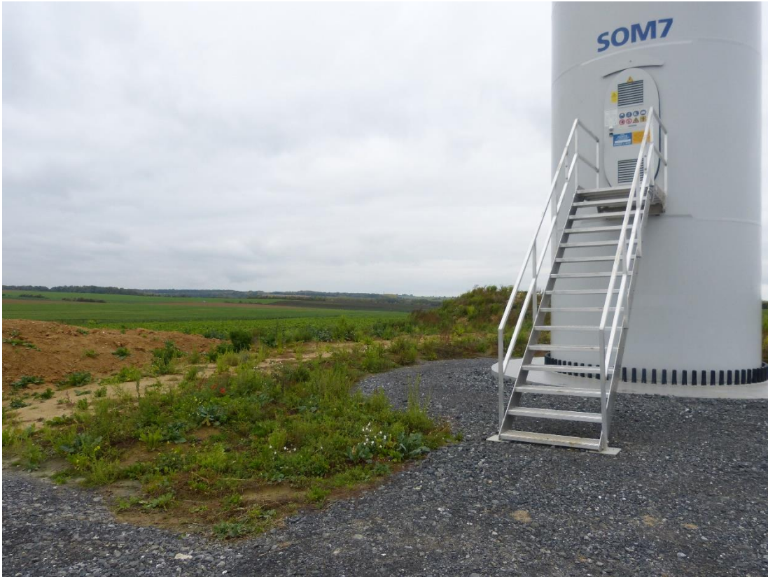
Figure 1: Exemple de plateforme investiguée (éolienne SOM7)
