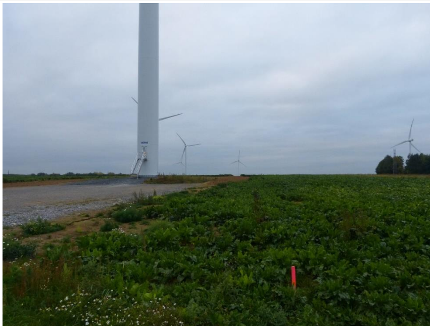
Figure 4: Exemple de balisage de la zone de prospection au pied d'une éolienne
